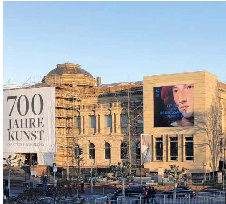
Die Fassadensanierung des Mainflügels wird 2019 fertiggestellt
