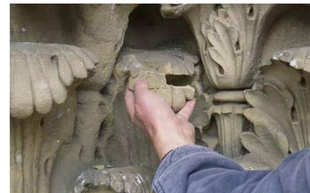
Eckkapitell mit stark entfestigtem Sandstein mit Lagerrissen, bei dem die Gefahr von großteiligen Abbrüchen besteht
